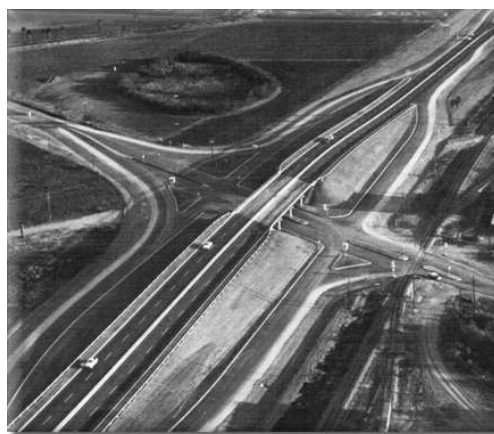
Фиг.4. Кръстовище на две нива с едно главно направление и светофарни уредби.
