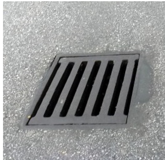
фиг.2 Чугунена решетка с размери 400x450 mm съгласно БДС 1623:1975.
