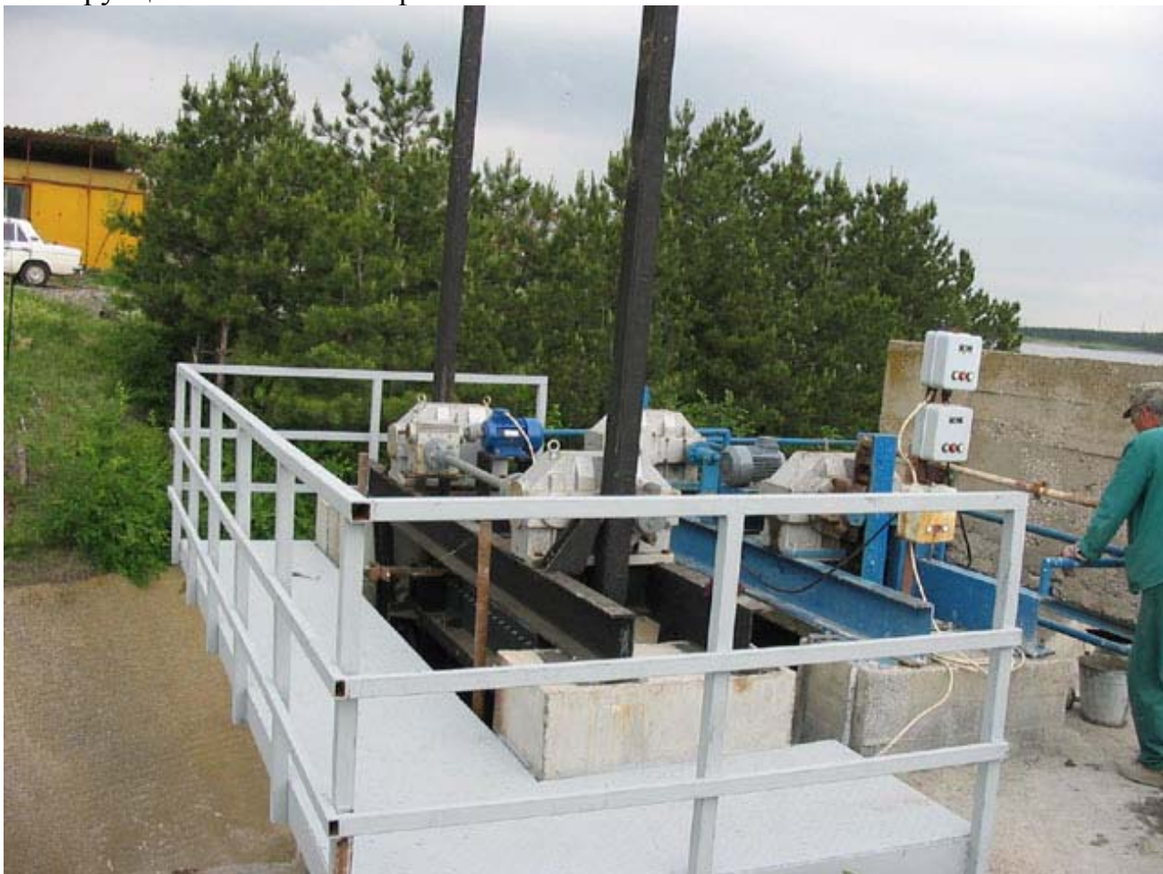
Фиг.1 Автоматизирана машина за почистване на събирателни скари за ВЕЦ
