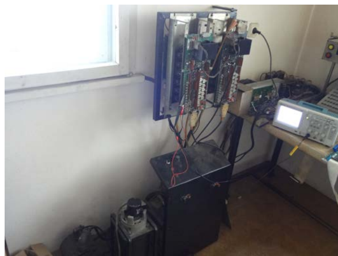
Фиг. 3. Настройка на подавателно електрозадвижване.
